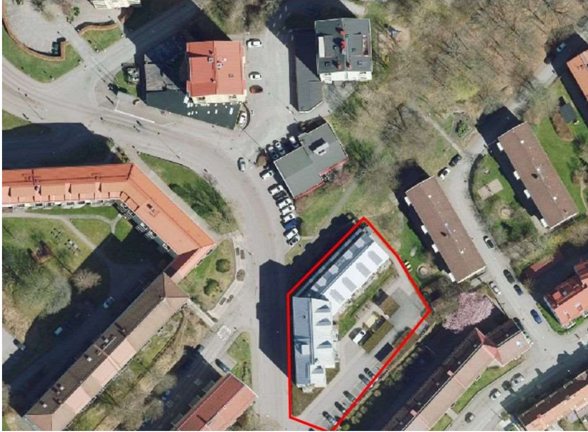
Figur 26: Kvarteret Åreskutan som uppfördes under 2000-talet på mark som tidigare var allmän plats park.
