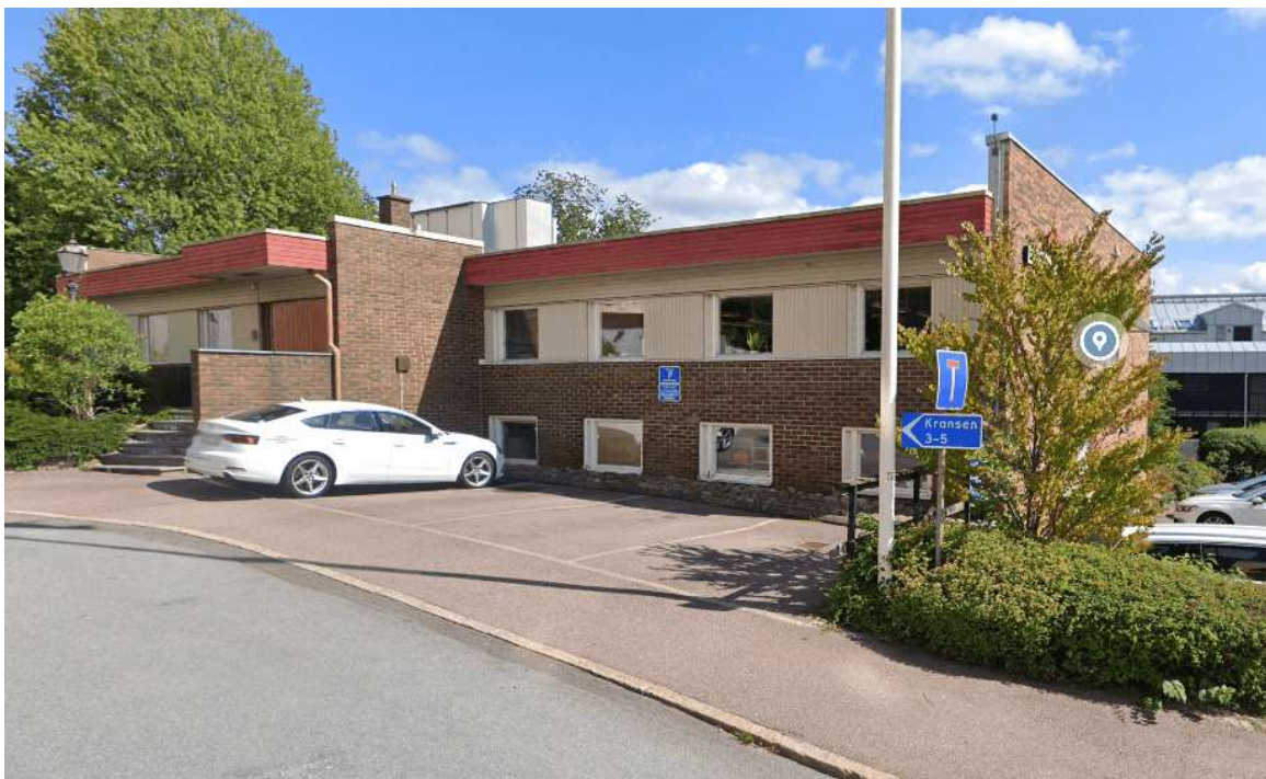
Figur 15: Befintlig byggnad från 1970-talet. Bild från google maps.
