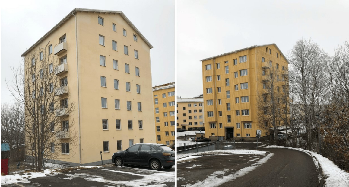
Figur 16: Exempel på funktionalistiska punkthus med inslag av nyrealism vid Wahlbergsgatan. Byggnaden på bilden till höger har tilläggsisolerats och förändrat fasadmateriel vilket gör att dess funktionalistiska karaktär delvis har förvanskats.
